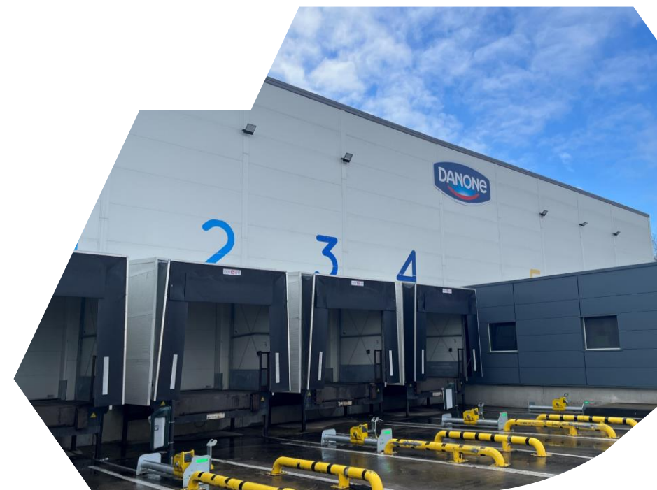
Plateforme logistique à Marly (57)
